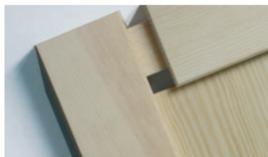
Assemblage par tenon et mortaise
