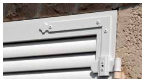
LE FERRAGE RÉNOVATION
